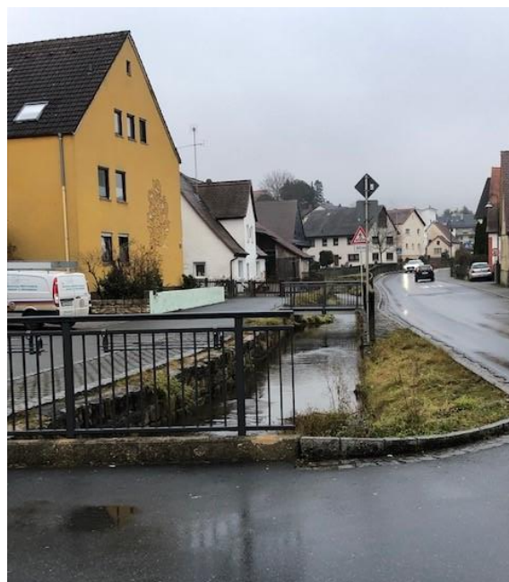
Foto 5: Blick auf Ehrenbach von Brücke Leutenbacher Str.
